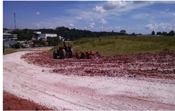
Arando Suelo con Cemento o Cal
